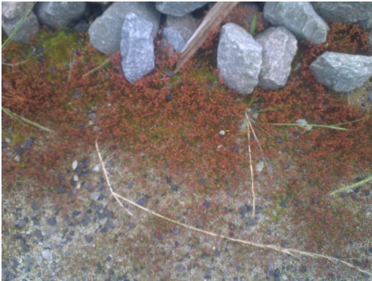
Figuur 20. Begroeiing van schouwpadmateriaal met mos.
