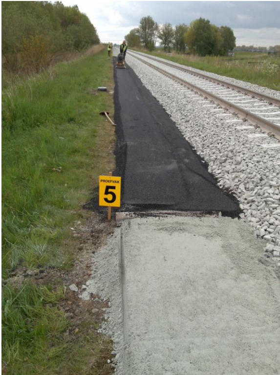
Figuur 2: Aanleg van de proefpaden
