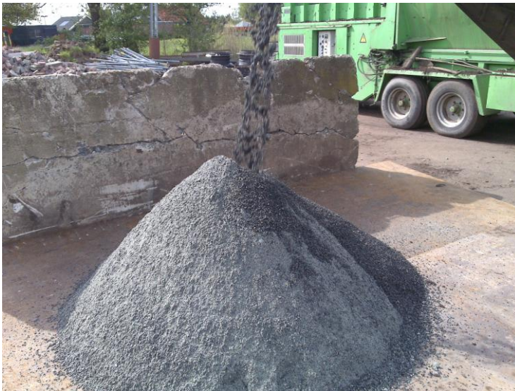
Figuur 1: Mengen van verschillende schouwpadmateriële
